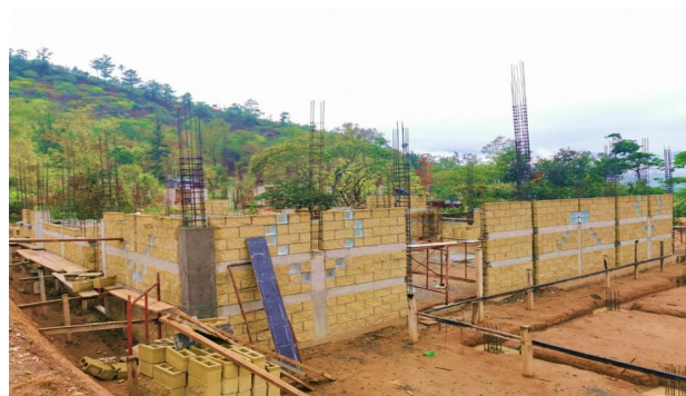
Módulo Administrativo (Oficinas)
