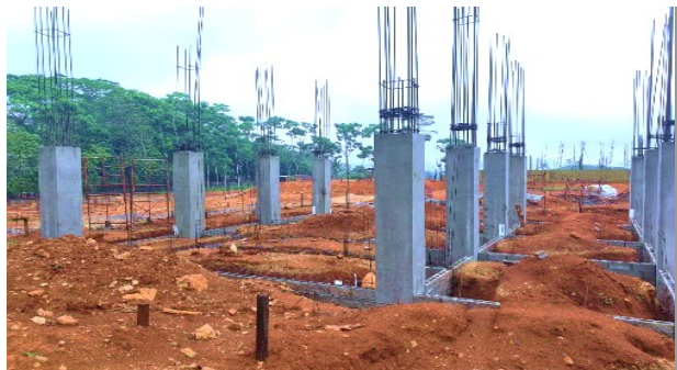
Módulo de Aulas y Laboratorios
