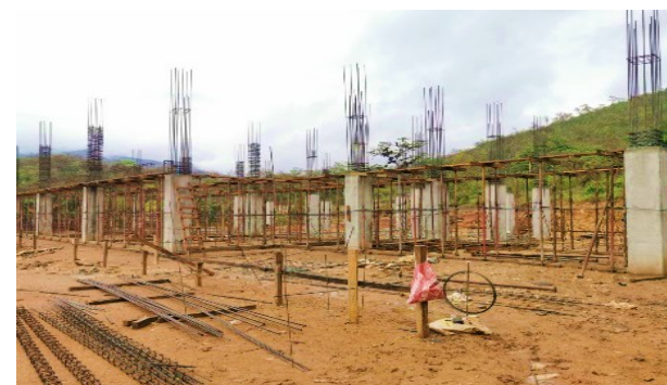
Módulo de Aulas y Laboratorios
